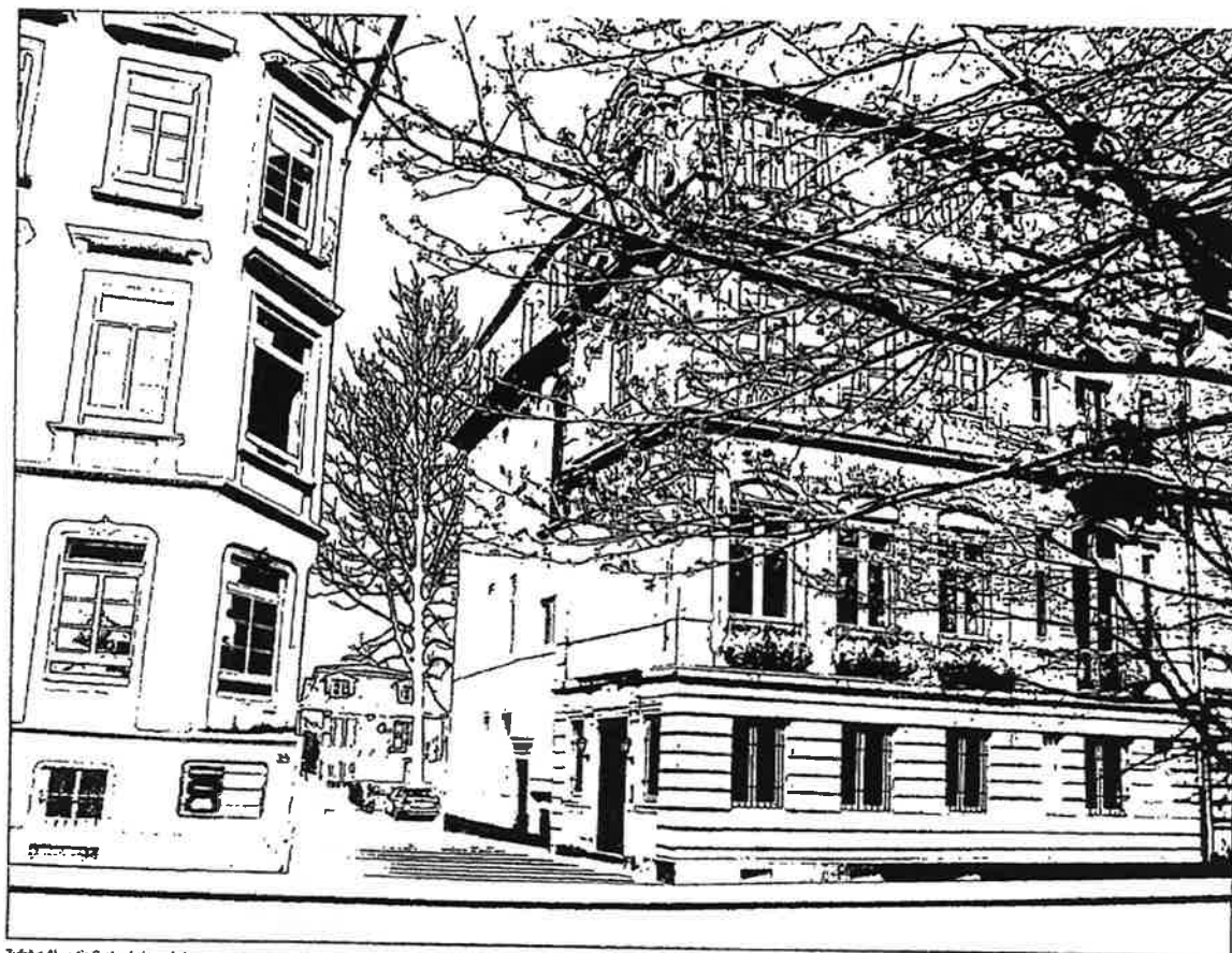
Zufahrt über die Bodentektoniker Anlage
