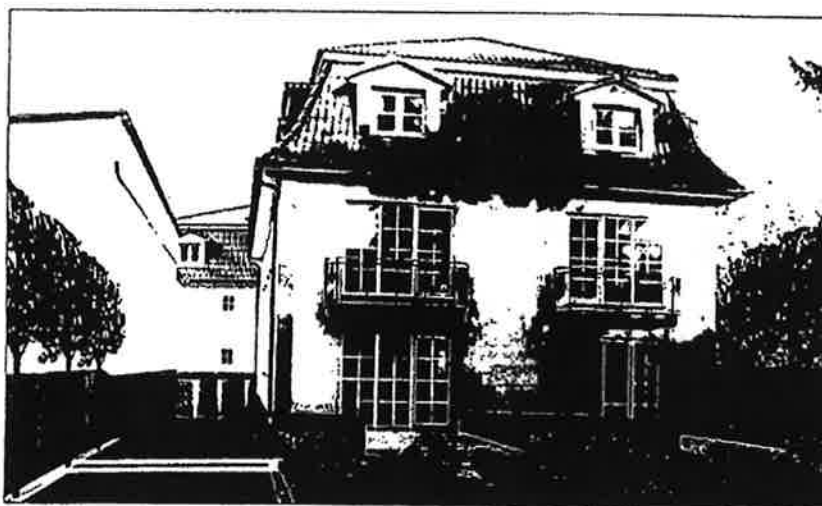
Voorraanzicht van de kleinste van 3 nieuwbouvilla's. Onder de drie villa's bevindt zich een parkeergarage voor 32 auto's. De achterste villa's beschikken over een zeer ruime stadstuin in een groene oase van rust.
